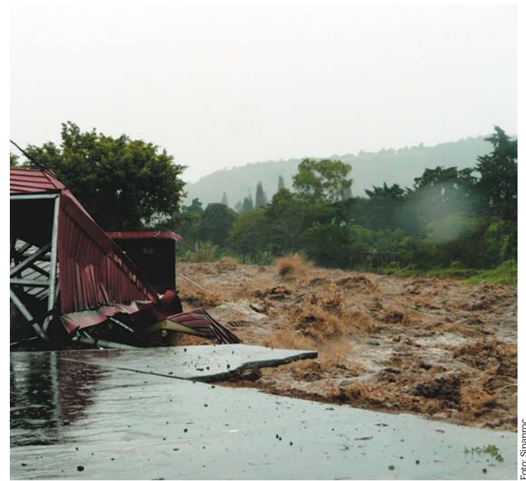
El río Caldera ha causado serios daños en Boquete.
