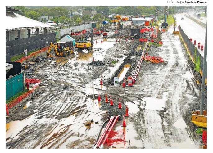
Las obras de la estación en que los pasajeros de la línea 3 del Metro podrán abordar la linea 1 en el área de Albrook, avanzan. Actualmente se prepara el pozo de ataque, que es el lugar por donde entrará la tuneladora para excavar el túnel que pasará bajo el cauce del Canal de Panamá.
