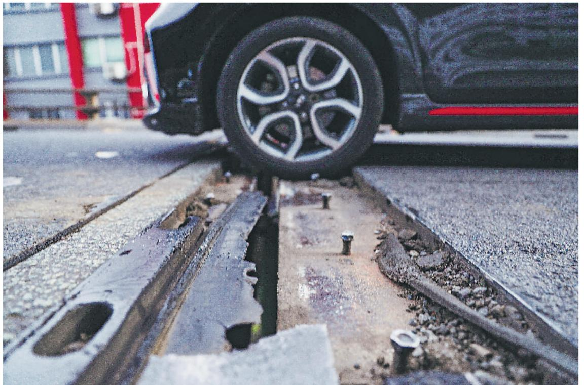
La unión entre la base y la estructura metálica del puente vehicular en la vía 3 de Noviembre, que conecta el área de la 5 de Mayo con la cinta costera, presenta un grave deterioro que podría causar serios daños a los automóviles que circulan por el lugar u ocasionar un accidente.
